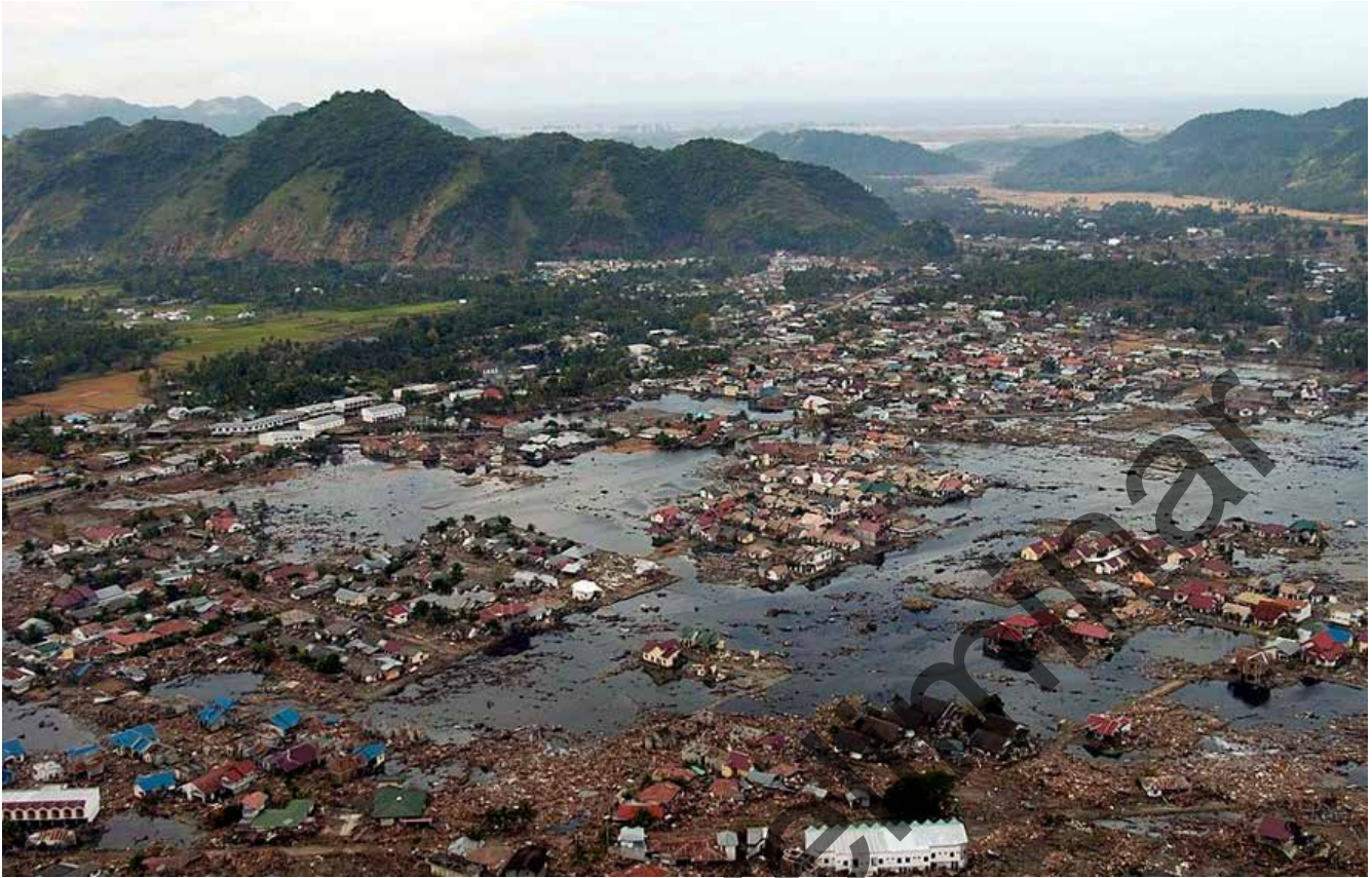
1. Pueblo en ruinas de la costa de Sumatra tras el tsunami que golpeó el sureste de Asia. 2 de enero de 2005.
